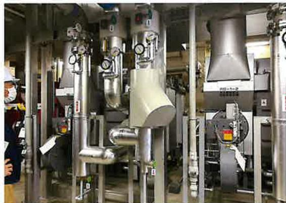
更新された吸収式冷温水発生機
