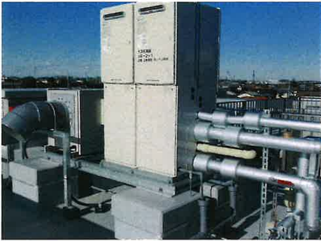
連結された高容量ガス給湯器
