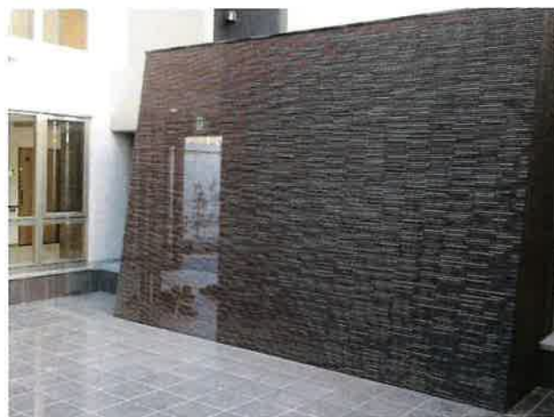
夜間はライトアップされる建屋内に作られたカスケード（滝）
