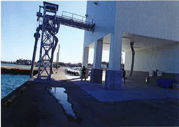
↑ 氷を船舶に直接放水する設備
