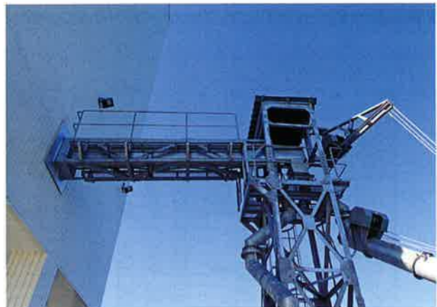
↑ スクリューコンベアーが屋内から屋外へ吐出している所
