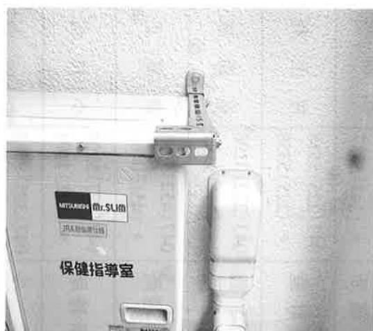
耐震工事とEHP室外機固定
