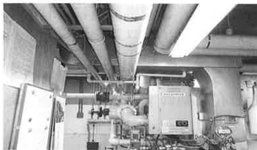
5階機械室の既存吸収式冷温水機
