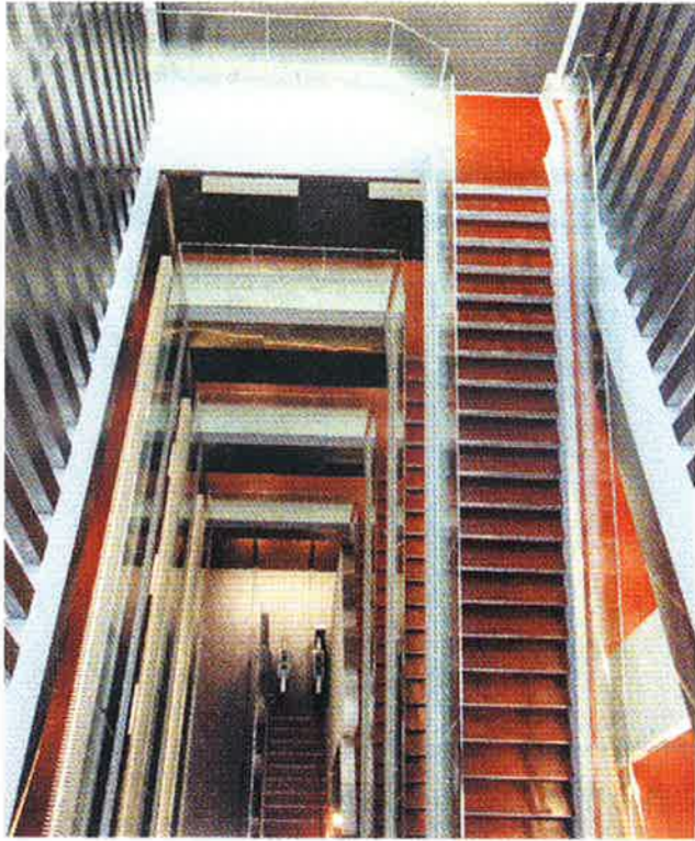
▲吹き抜け 5階より階下を望む
