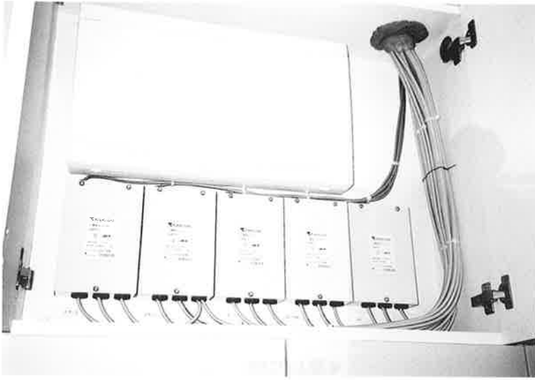
◀ 住戸分電盤及び計測装置
