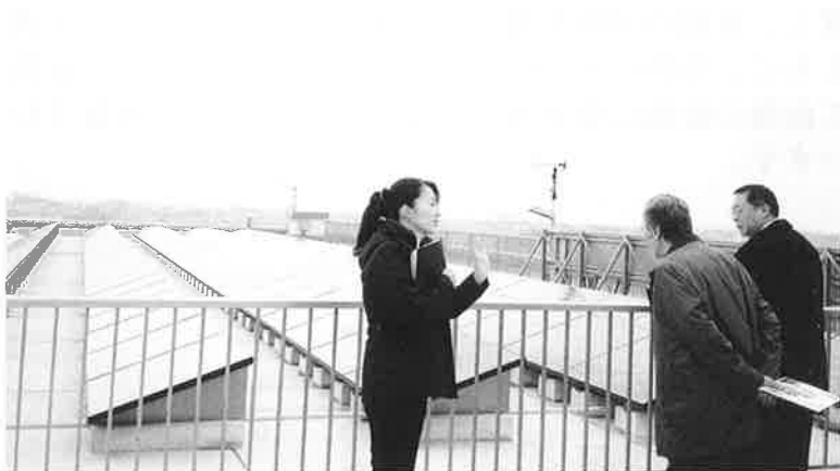
▲太陽光発電 発電容量：約25kW (1.3㎡/枚、140枚設置)
